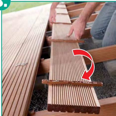
**Tipp:** Bei Harthölzern gegebenenfalls vorbohren, damit das Holz nicht reißt, oder die Schrauben abbrechen.
