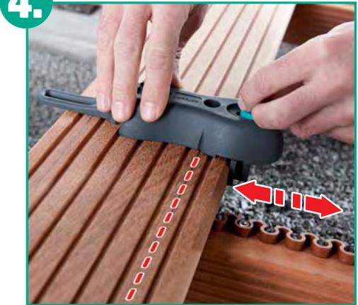
Legen Sie das **Terrassenbohrmobil** auf die Diele und stellen Sie mithilfe der seitlichen Kerbe die hintere Bohrbuchse genau auf die entsprechende Markierungslinie ein.
