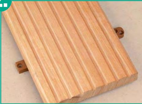
Danach wird der Verbinder soweit auf dem Dielenbrett verschoben, dass ein Schraubenloch gerade noch an der Brettkante vorsteht. Mit vier Schrauben wird der Verbinder anschließend auf dem Dielenbrett befestigt.
