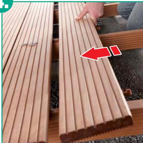
Der vordere Verbinderüberstand wird einfach unter die vorherige Diele geschoben. Damit wird die Diele an der Vorderkante automatisch fixiert und muss nur noch an der Hinterkante mit zwei Schrauben befestigt werden. Die Verbinder dienen dabei gleichzeitig als Abstandhalter zwischen Diele und Tragholz und verhindern so Staunisse, die zur schnelleren Verrottung des Holzes führen kann.
