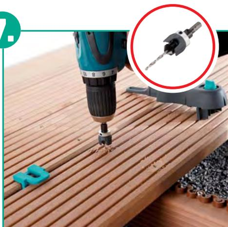
Danach Bohrmobil zur Seite legen und beide Löcher fertig bohren. Dabei werden auch gleich die Löcher für den Schraubenkopf gesenkt. Mit dem **Vorbohrer mit Senker und Tiefenstopp** kann die Senktiefe genau eingestellt werden.
