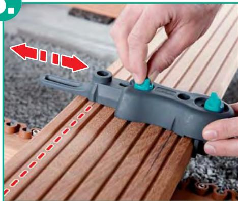
Stellen Sie auf die gleiche Art auch die vordere Bohrbuchse mithilfe der seitlichen Einstellkerbe auf die zweite Markierungslinie ein. Legen Sie das Dielenbrett anschließend positionsgenau auf die Traghölzer auf.
