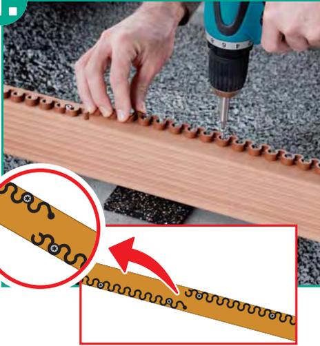
Schrauben Sie zuerst die **Distanzleisten** auf die Tragbalken. Die Leisten sollten dabei versetzt einmal am linken und danach am rechten Balkenrand befestigt werden.
