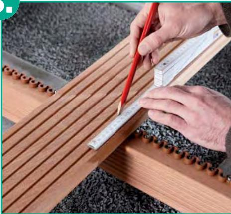
Markieren Sie sich auf der Dielenoberseite mit zwei Linien die beiden Bohr- bzw. Schraubpositionen. Achten Sie darauf, dass die Bohrung nicht in einer der Rillen bzw. Nuten im Brett liegt.
