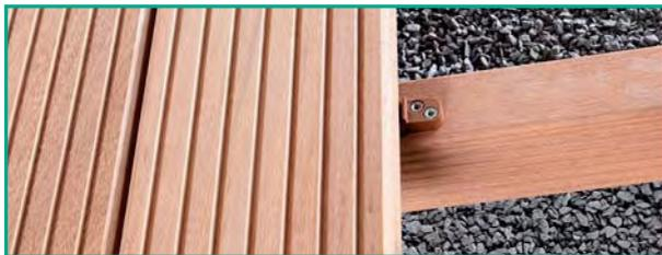
Der Deckverbinder wird auf die Dielenrückseite geschraubt, daher ist auf der Oberseite keine Verschraubung sichtbar. Am hinteren Überstand des Verbinders wird die Diele einfach mit zwei Schrauben auf dem Balken befestigt.
