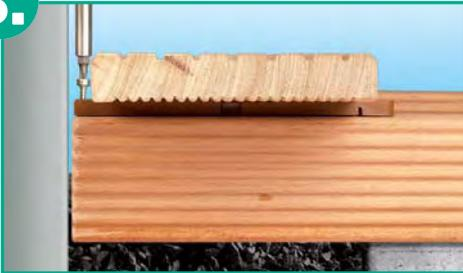
Dann legen Sie das Brett mit den gekürzten Verbindern bündig an die Hauswand. Im Bereich zwischen Hauswand und Dielenkante bleibt auf diese Weise 1 cm Luft und das Dielenbrett kann durch das hintere Schraubenloch mit einer Schraube und im vorderen Bereich mit zwei Schrauben mit den Tragbalken verschraubt werden.
