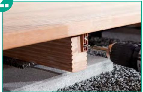
Drehen Sie anschließend das Brett um und schieben Sie die Verbinders wieder unter das vorherige Dielenbrett. Zum Schluss schrauben Sie den Verbinders noch an der Stirnkante des Trägerbalkens mit zwei Schrauben fest.
